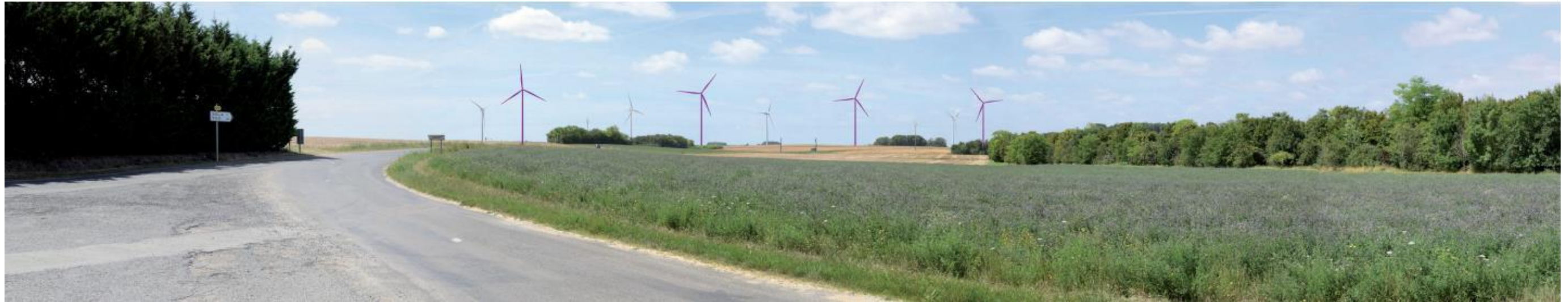
Figure 402 : Vue sur le projet éolien depuis la D.92 en sortie sud-ouest de Liniers. (photomontage 26)
