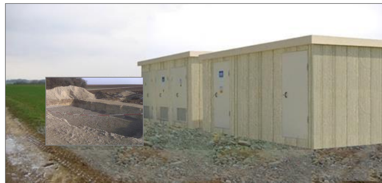
Figure 3.13 : Illustrations photographiques de la pose du poste de livraison.
