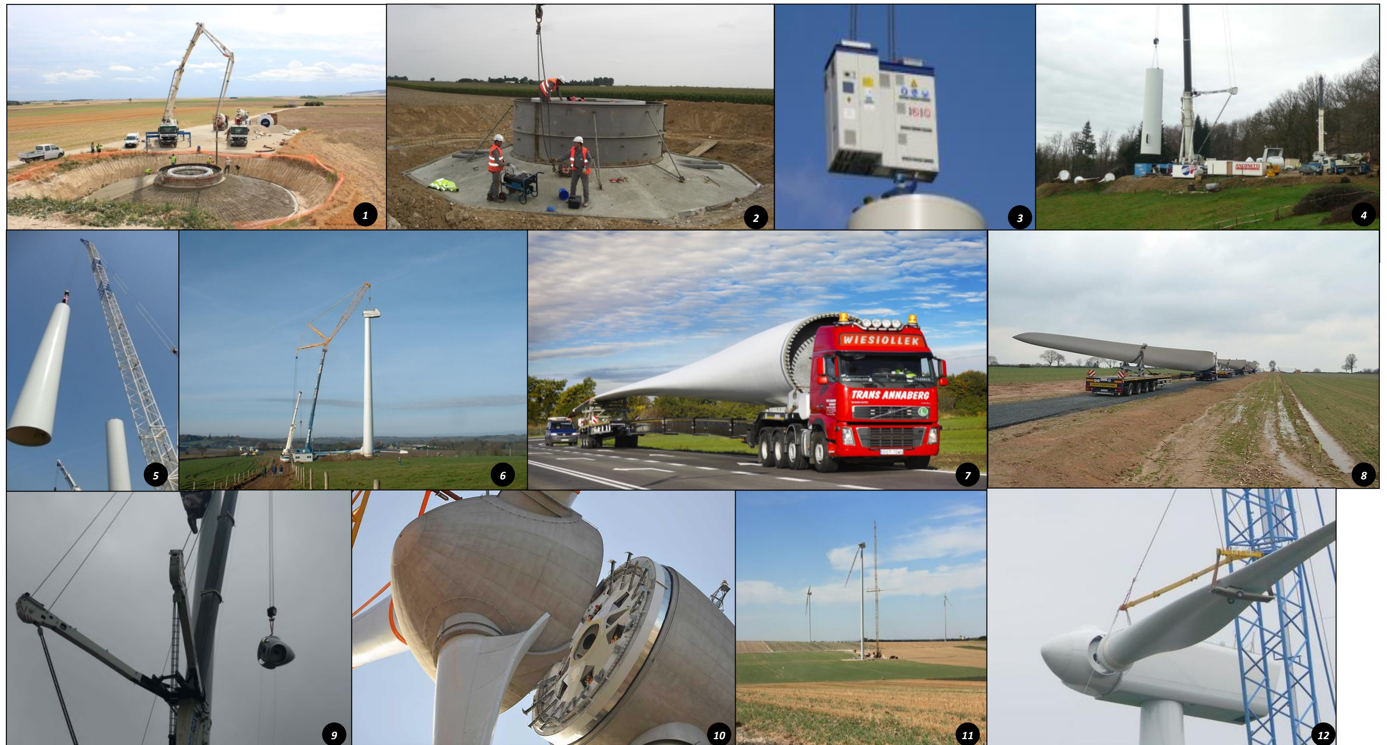
Figure 304 : Illustrations photographiques des phases de montage des éoliennes
