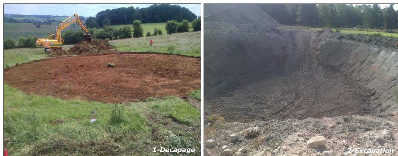
Figure 3.10 : Illustrations photographiques de la préparation d'une fondation
