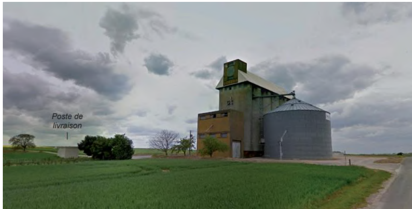
Figure 301.: Localisation du poste de livraison
