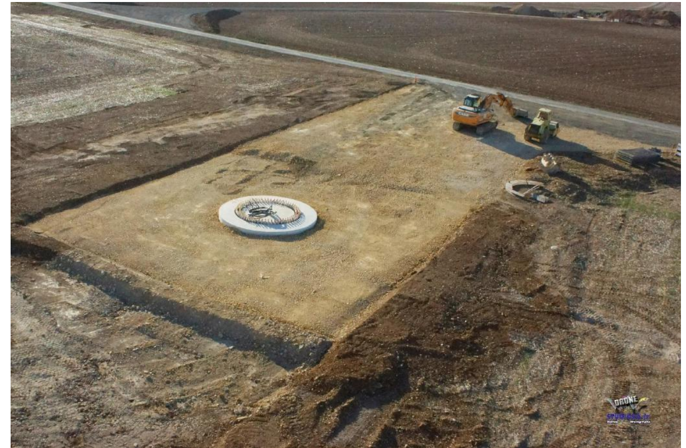
Figure 290.: illustration photographique d'une plateforme de grutage
