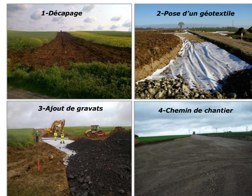
Figure 309 : Illustrations photographiques d'une construction de voirie
