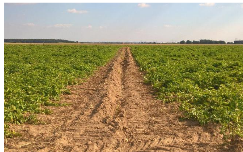
Figure 297 : Tranchée pour le passage de réseau électrique HTA à partir d'un soc tracté
