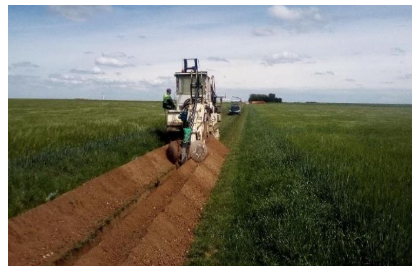
Figure 296 : Tranchée pour le passage de réseau électrique HTA à partir d'une trancheuse
