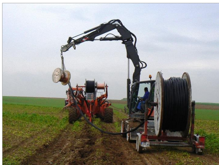
Figure 298 : Illustrations photographiques de la pose d'un câble HTA avec la méthode du soc tracté
