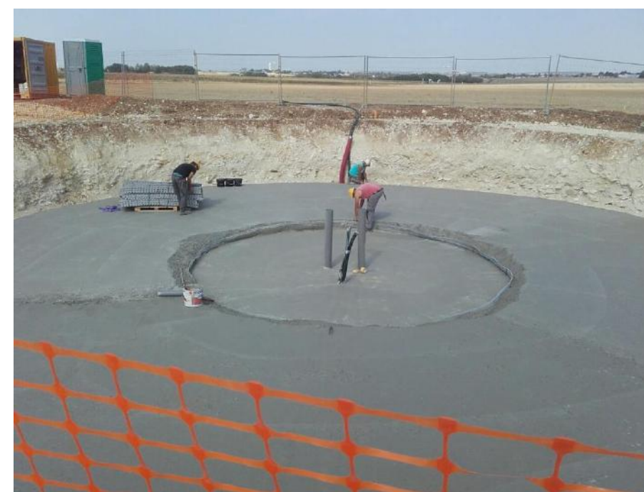
Figure 292 : Illustrations photographiques des étapes de construction d'une fondation d'éolienne
